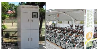
自転車への給電装置は非常時には防災電源として活用
