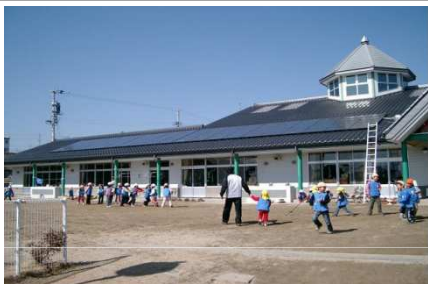
保育園に設置された 太陽光発電
