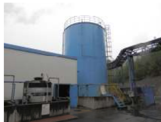
処理水タンク
