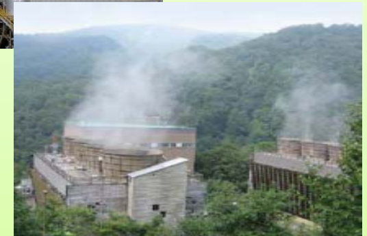
【地熱発電設備】
