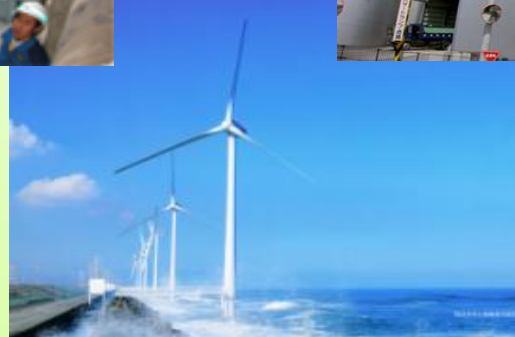
【風力発電設備】
