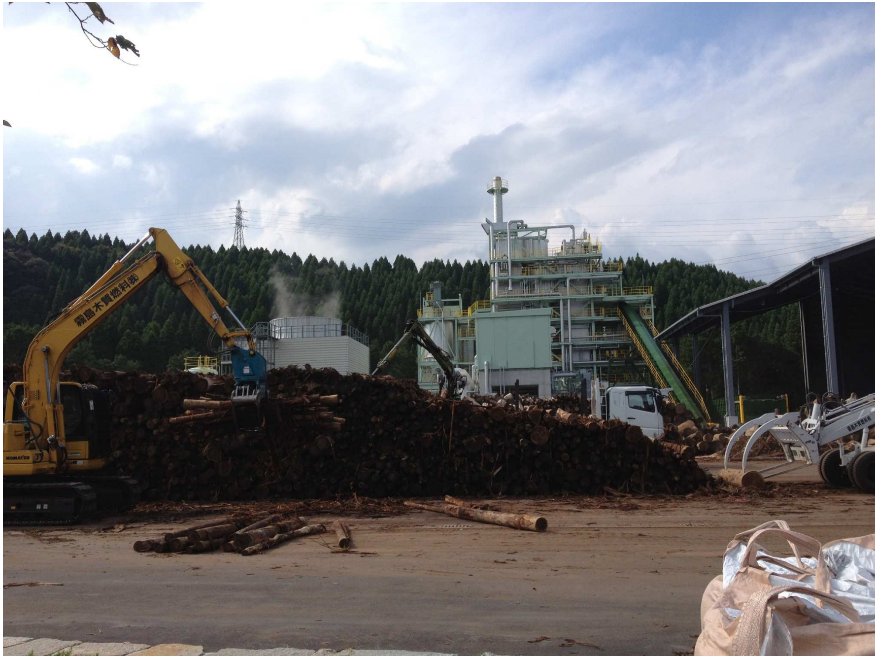
木質バイオマス発電施設(霧島木質発電) 5,750kW 未利用材
