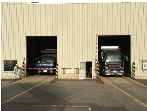
2基のトラックダンパーで投入。4つの燃料バンカーに振り分け。
