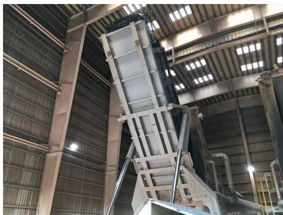
2基のトラックダンパーで投入。4つの燃料バンカーに振り分け。
