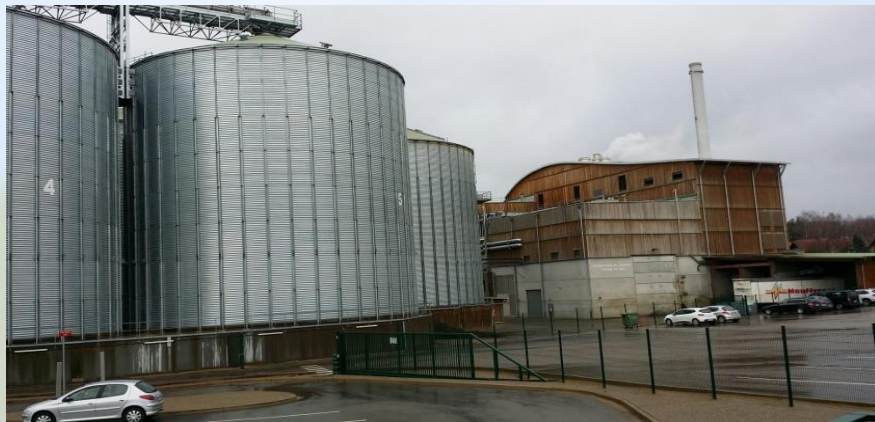
B 製品ペレットサイロと発電所
