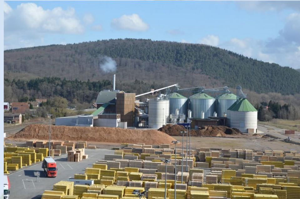
A ペレット工場全景 (Rudnick社資料より)
