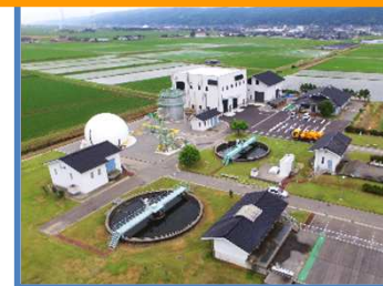
<中能登町 バイオマスメタン発酵施設>
