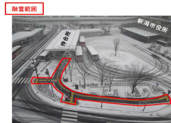
下水管渠からの採熱による融雪 (新潟市)
