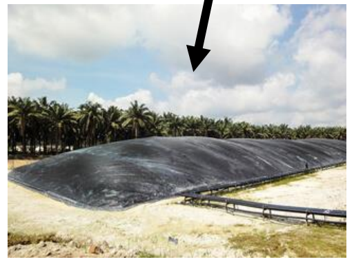
カバーラグーンによるメタンキャプチャー 写真：Greenlagoon HPより
