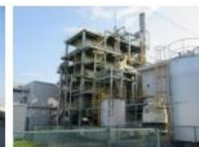
木質バイオマスボイラ施設
