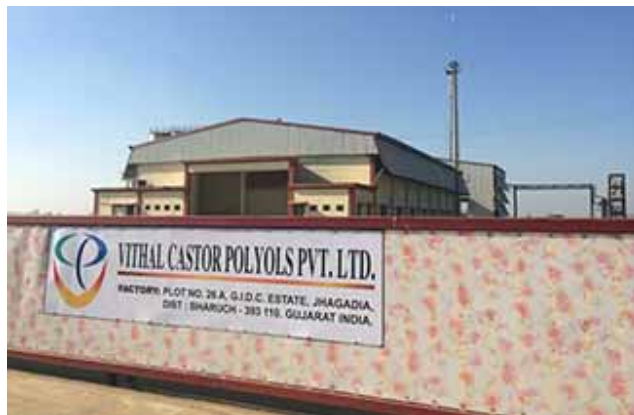
VCP工場外観
