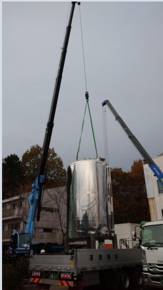
年末年始ぶっ通しで行われた薪ボイラーの設置工事(2020)
