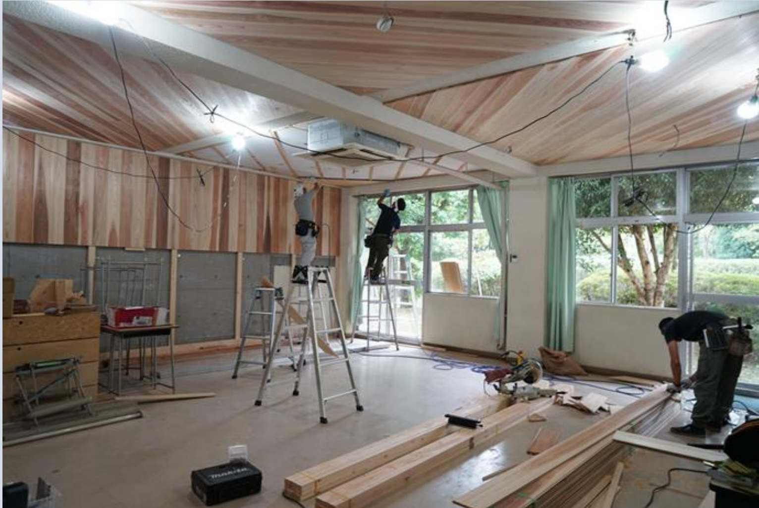
教室改修工事
