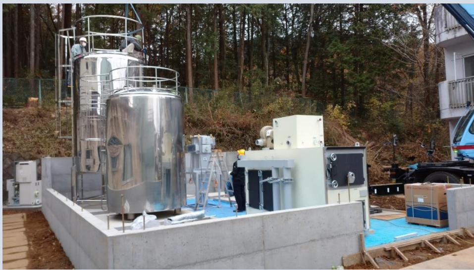
年末年始ぶっ通しで行われた薪ボイラーの設置工事(2020)
