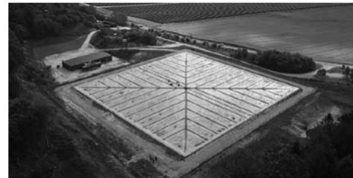
写真 ドロニングルン (Dronninglund) の37,573㎡の太陽熱収集パネルと62,000㎡の季節間蓄熱槽 (出典: http://arcon-sunmark.com/newsandmedia/dronninglund-district-heating-denmark )
