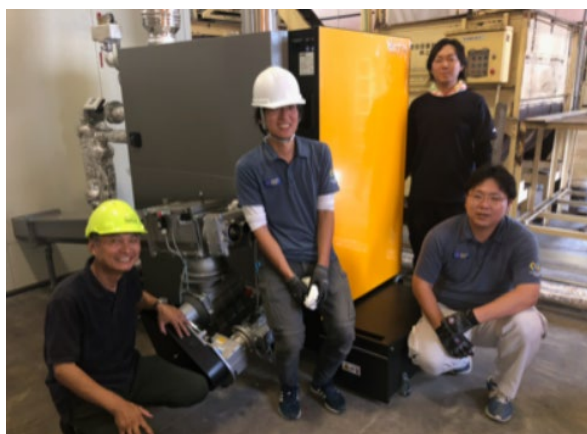
設置した職員（倉庫内設置）
