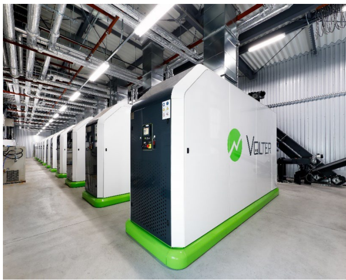
発電所内部（Volter 40が12台）
