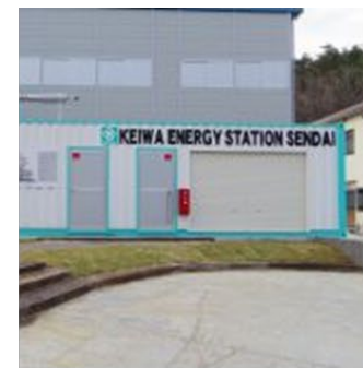
ケイワ・エネルギー・ステーション 宮城県仙台市
