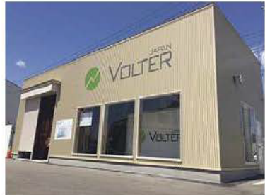
小型バイオマス発電所(40kW)
