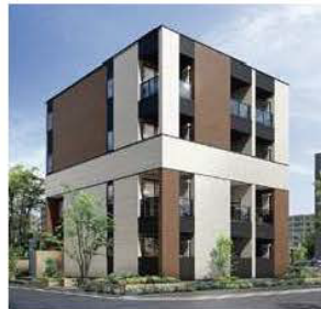
CLT(直交集成材)を用いた木造4階建ての集合住宅 (温室効果ガス排出の削減や工期短縮の効果)
