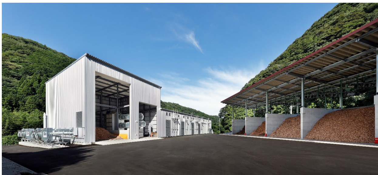
発電所とチップヤード
