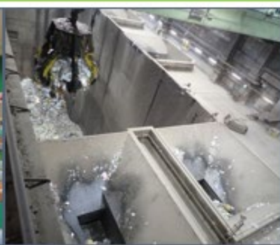
クレーンで選別機へ投入
