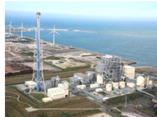
鹿島火力発電所
