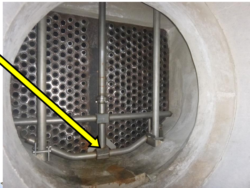
ボイラ内部 (燃焼ガス入り側)
