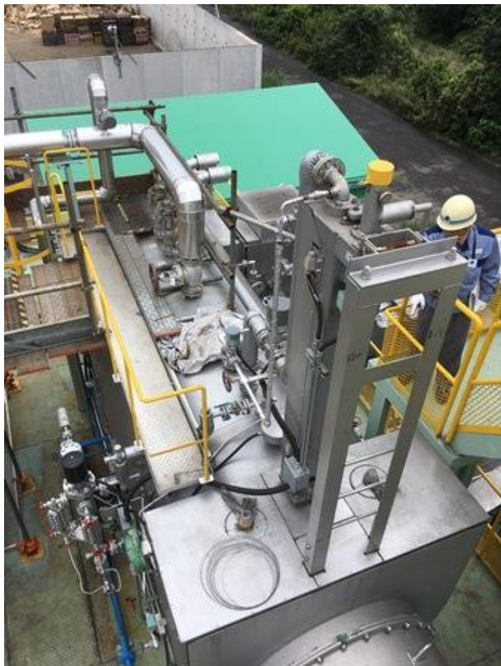
ボイラ外観 (手前：燃焼ガス入り側)
