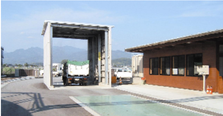
車両消毒設備
