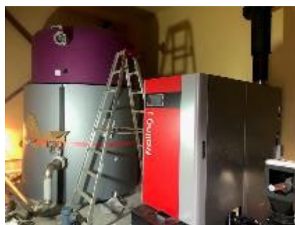
【新設】150kW×4台 チップボイラー (フローリン社製) と蓄熱タンク
