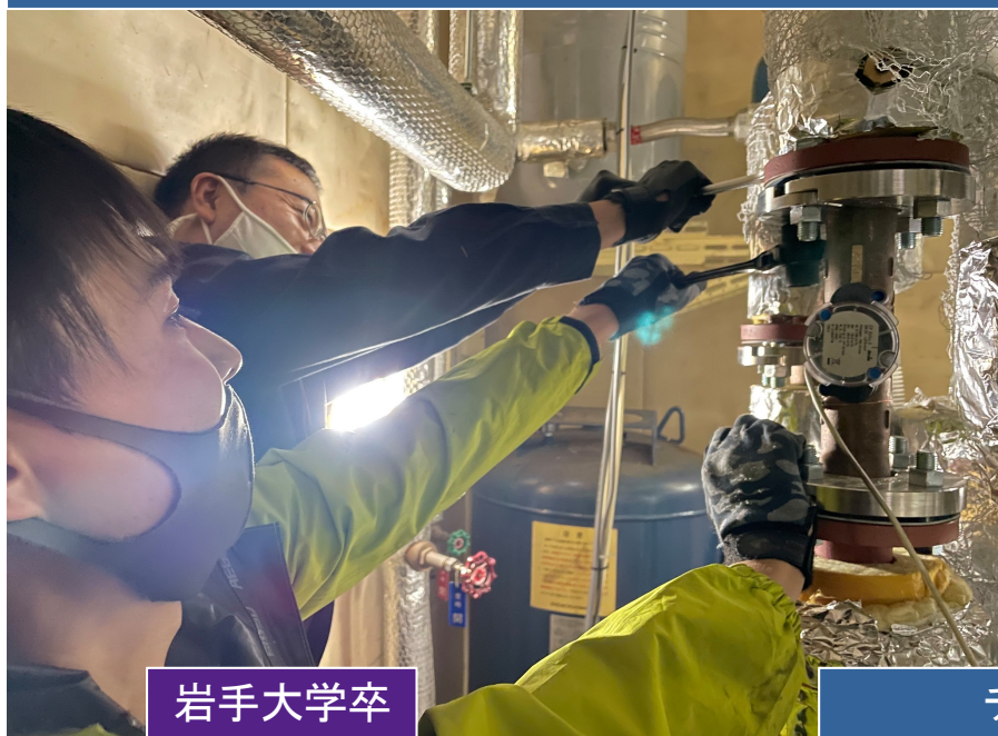
乾燥機の試運転調整
