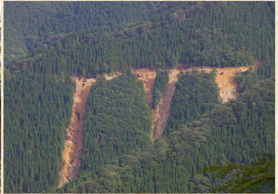
実際に崩壊したところ。その際に盛った土だけではなく、地山も引きずられて崩壊している(右)。
